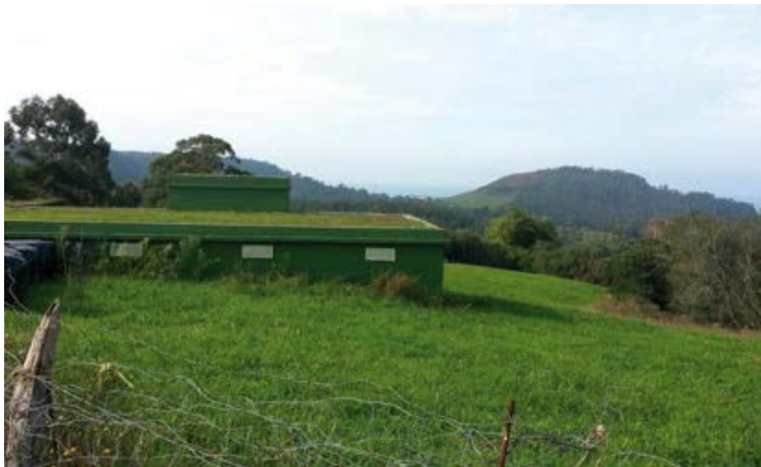
Cultivo en cubierta de una cisterna de aguas en el concejo de Ribadedeva (España).
