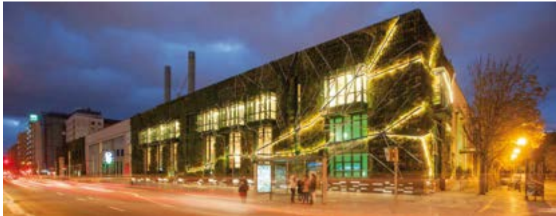
Europa Palacio de Congresos; photo source: Greenroofs.com. Photo by Quintas Fotografos, Creative Commons, Urbanarbolismo ( http://www.urbanarbolismo.es/blog/fachada-vegetal-del-palacio-de-congresos-de-vitoria/ ).
