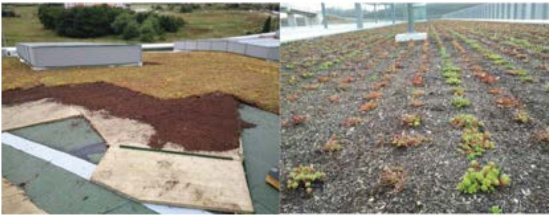
Cubiertas intensivas con sustrato de compost vegetal y grava volcánica
